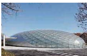
井上公園水泳場
